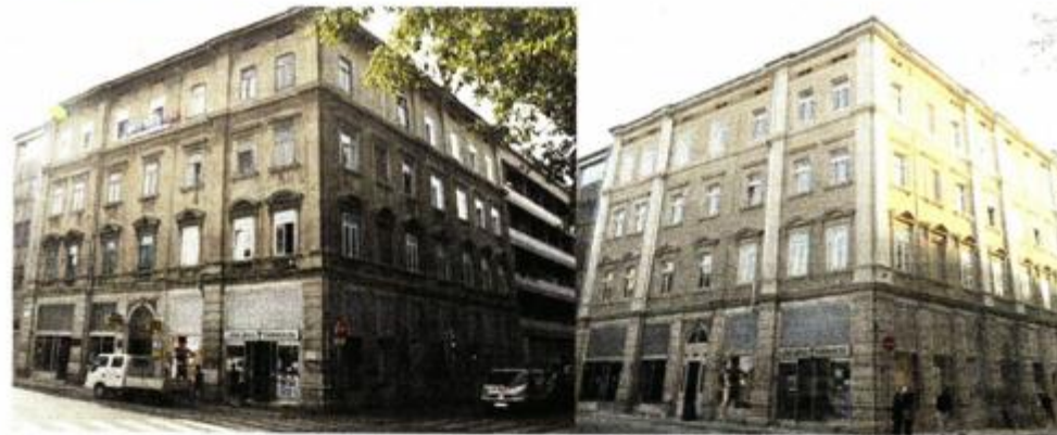
Zgrada na Giardinima prije i poslije obnove
