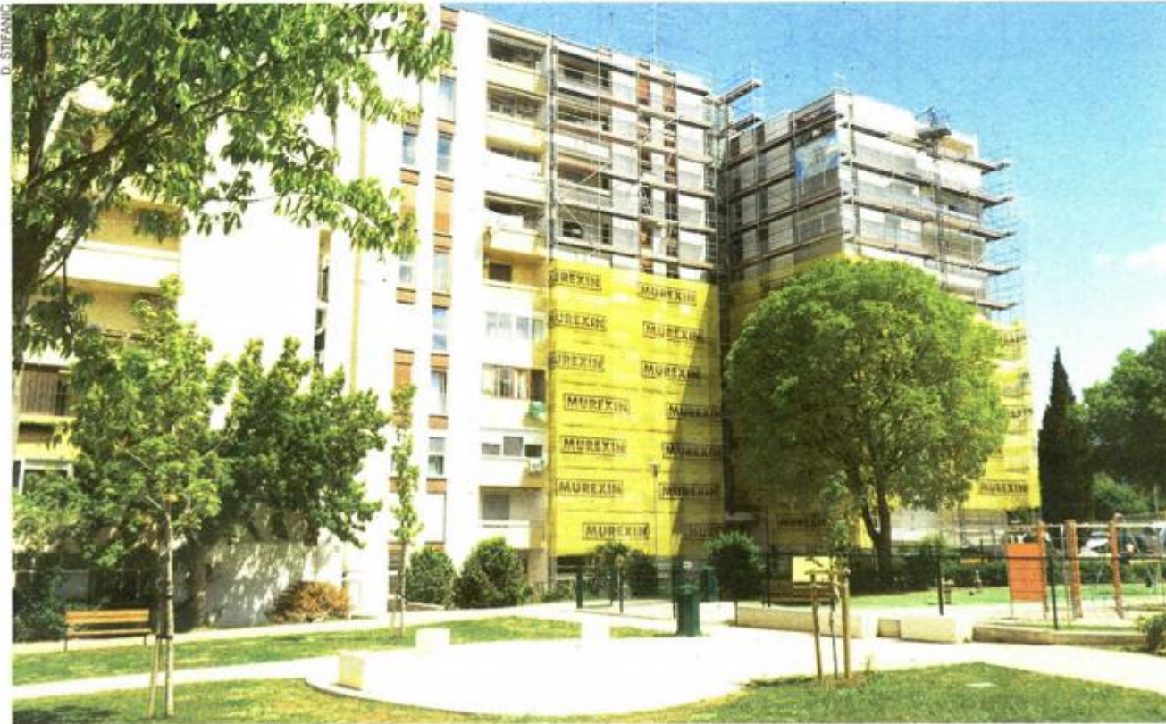
Generalna sanacija fasade u Koparskoj 58
