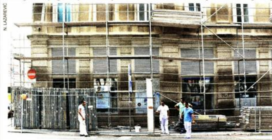
U sklopu Dolcevite dosad je obnovljeno 48 fasada
