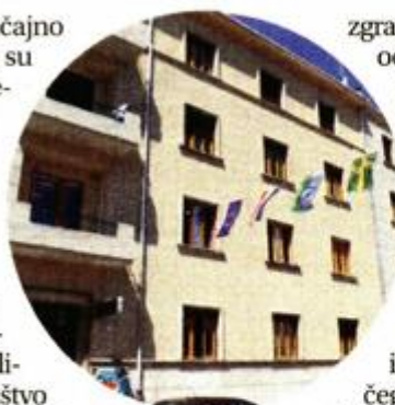
Energetska obnova zgrade koštala je 2,6 milijuna kuna
