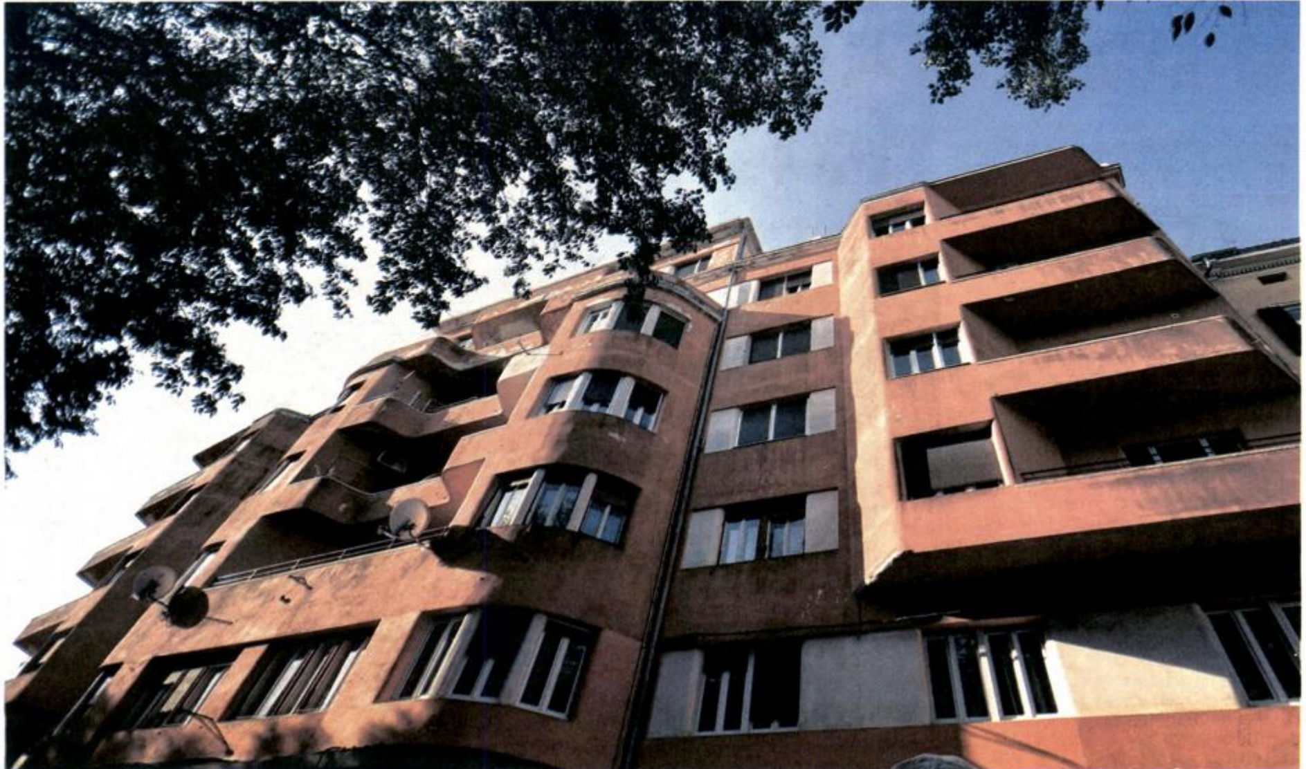
Stambena zgrada na Giardinima priprema se za obnovu krovista i pročelja
